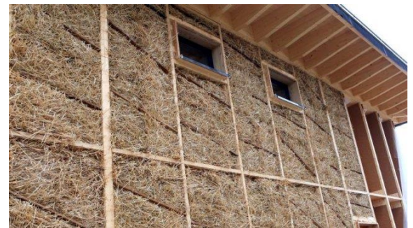
Picardie Pass Rénovation, Energetska obnova zgrada, Francuska
