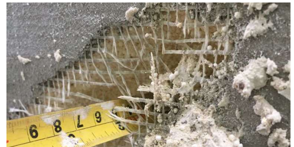
Figure a. Dicke des Isolationsmaterials
