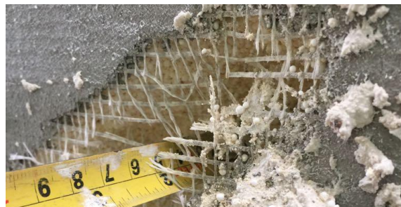
a. ábra A szigetelő réteg vastagsága
