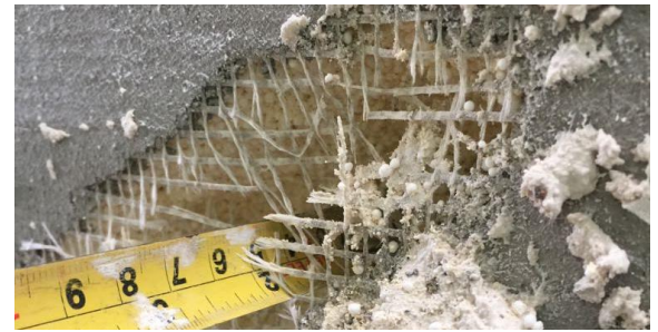
Figura 1 Spessore dello strato di isolamento
